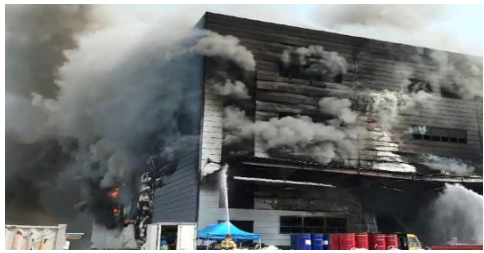
이천 물류센터 신축공사 중 화재 (‘20.4.29 사망 38, 부상 10)
