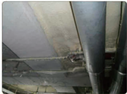
일반 건축물 천정부 스프레이 시공
