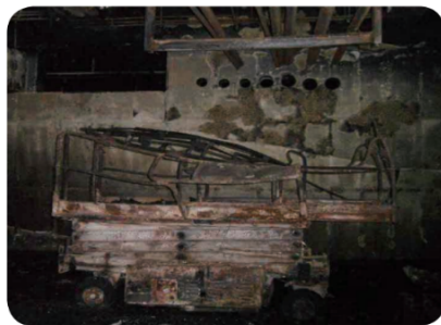
가설전등 스파크로 인한 우레탄폼 화재로 13명 사상
