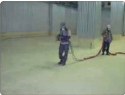
냉동창고 벽면·바닥 스프레이 시공
