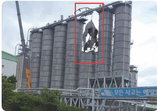
[사고 발생 후 파손된 사일로]
