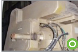
동력전달부 덮개 설치
