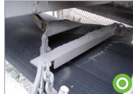
테일 드럼 보호를 위한 V형 스크레이퍼 설치
