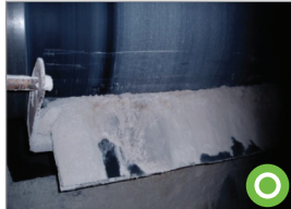
리턴 롤러 코팅방지를 위한 스크레이퍼 설치
