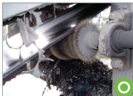
브러쉬형 스크레이퍼 설치
