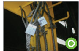
와이어로프 태그 설치 상태
