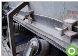
스커트 설치 상태 양호
