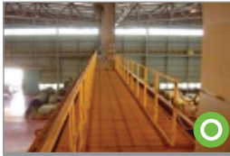
안전난간 설치
