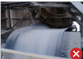
벨트 사행(蛇行) 상태 불량
