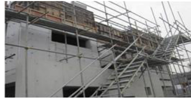
작업발판 · 안전난간 · 계단 설치
