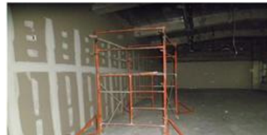
상부작업대 안전난간 설치
