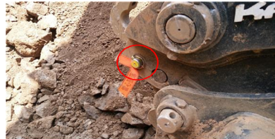
굴착기 안전핀(퀵커플러) 설치
