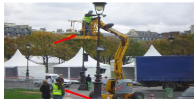
가로등 · 신호등 작업발판 설치
