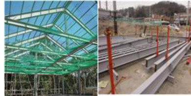
추락방호망 · 안전대걸이시설 설치
