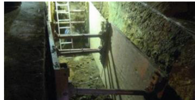
트렌치굴착 흙막이보공 설치
